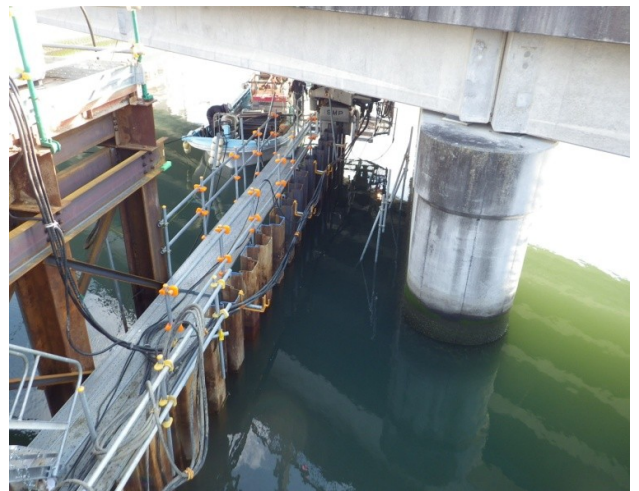
写真：橋梁下における仮設工（矢板圧入）状況
